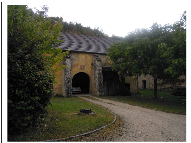
Porte cochère de la grange-écurie, sommée des armoiries de l'abbesse qui avait reconstruit les bâtiments au XVI e siècle.
