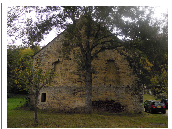
Vestiges de deux cheminées du logement des religieuses autrefois établi contre ce mur Est du cellier.
