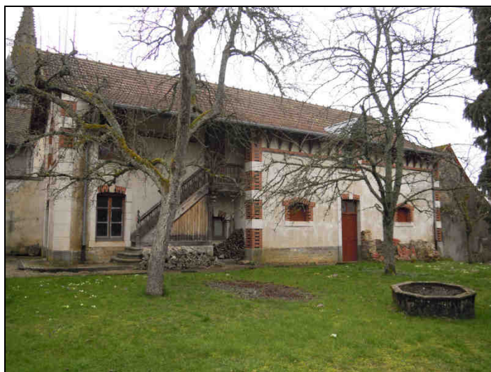
Le commun abritant la salle de bain. (Cliché de l'auteur)
