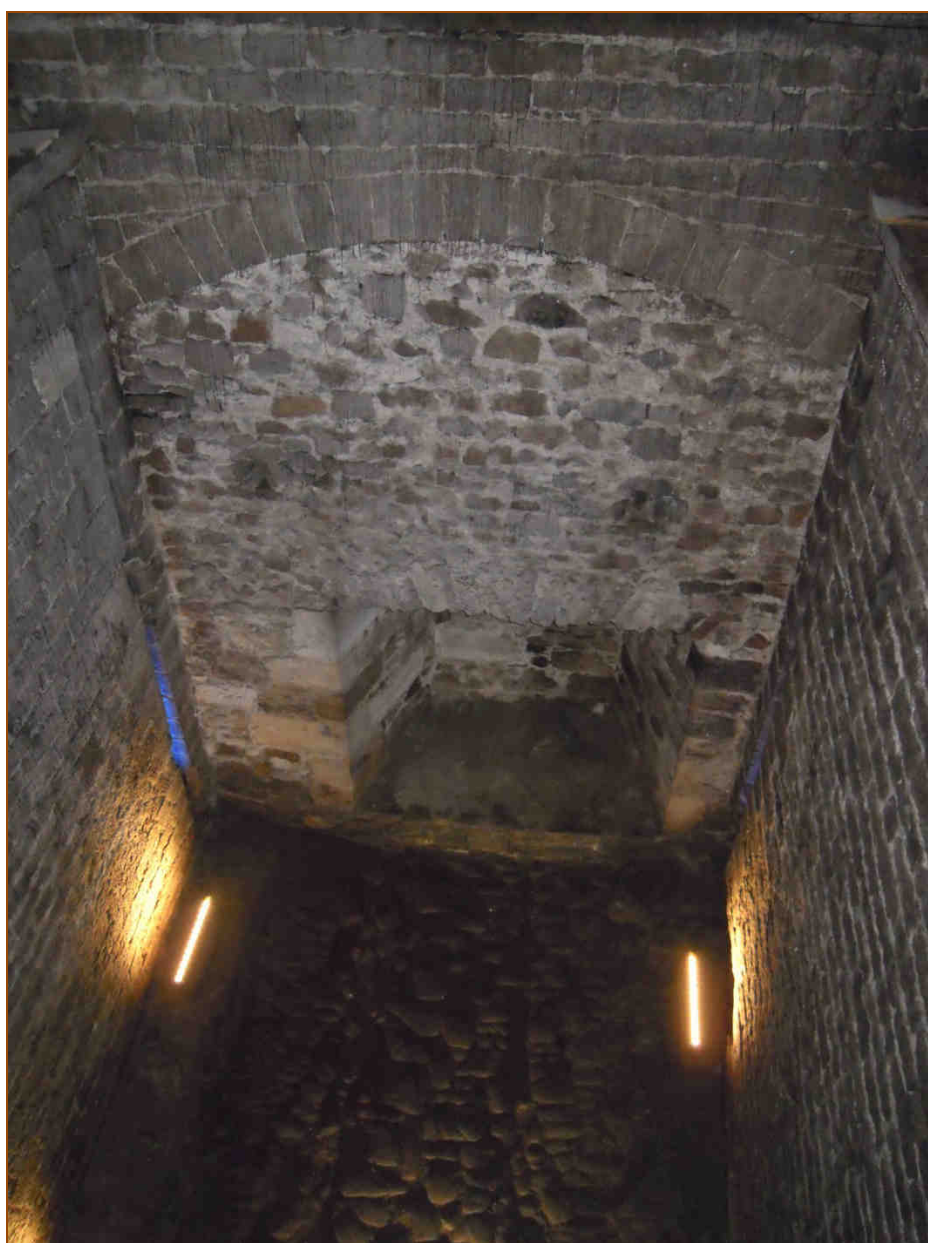
Dans la substruction de la Tour de l'Orle d'Or on distingue l'arche (aujourd'hui murée) sous laquelle on pénètre dans la cité, et même les pavés de la rue tout en bas. (Cliché de l'auteur)
