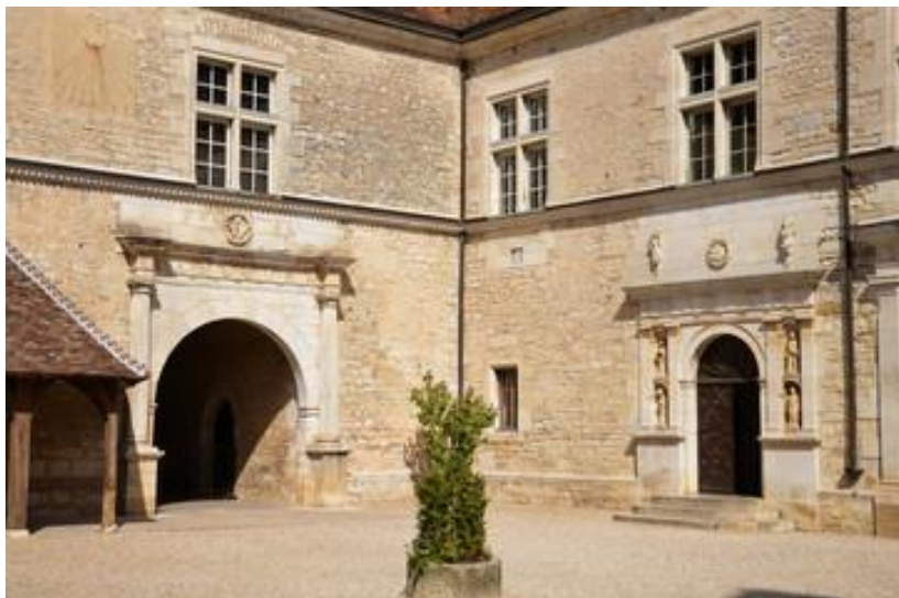
Cour du château, appartements Renaissance restaurés par Léonce Bocquet, coll. privée
